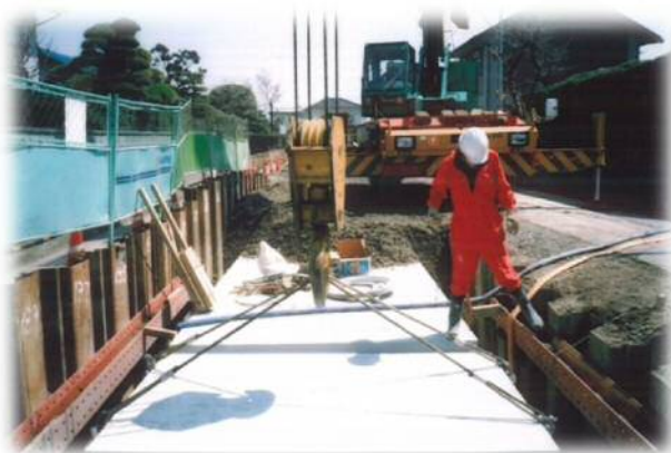
浅川1号雨水幹線工事 状況写真
