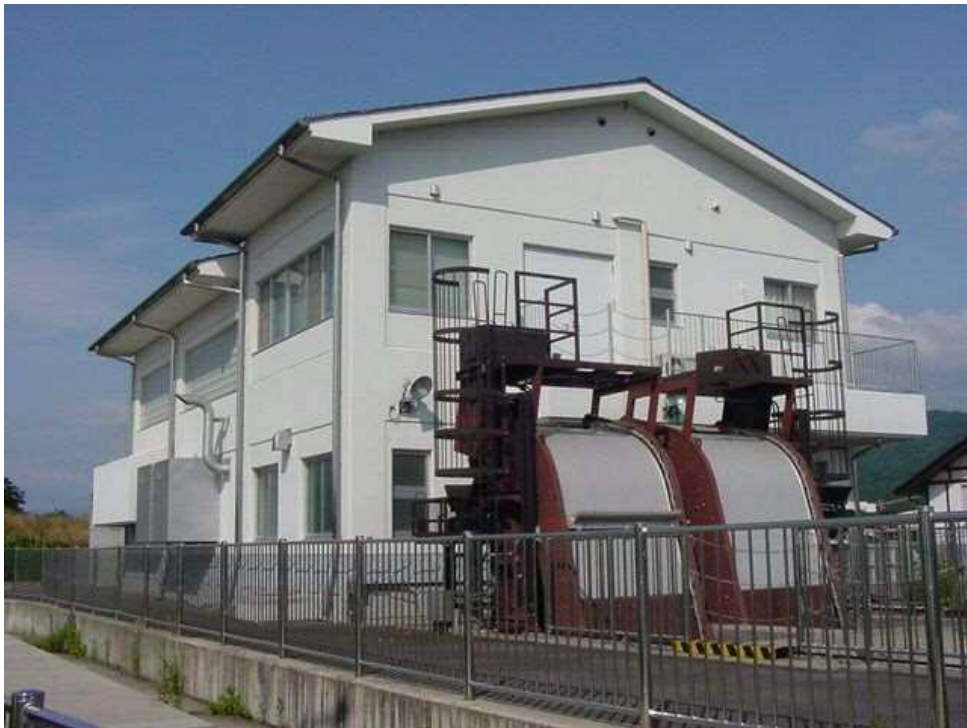
長野市公共下水道事業（雨水） 寺尾ポンプ場 平成12年度供用開始
