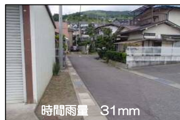
雨水渠整備後 (H27)
