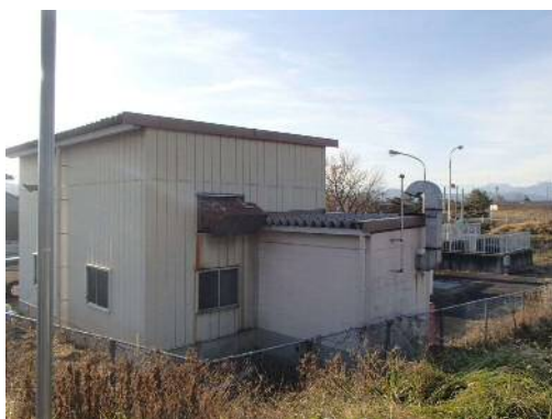
西田川ポンプ場（全景①）
