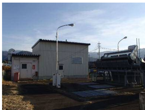
西田川ポンプ場（全景②）
