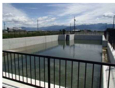
北堀雨水調整池
