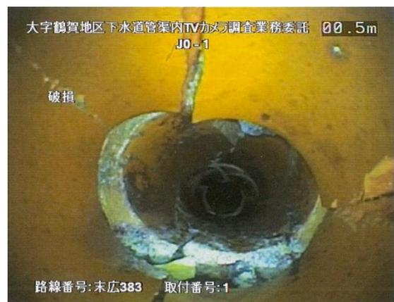
陶管製取付管の破損・扁平事例
