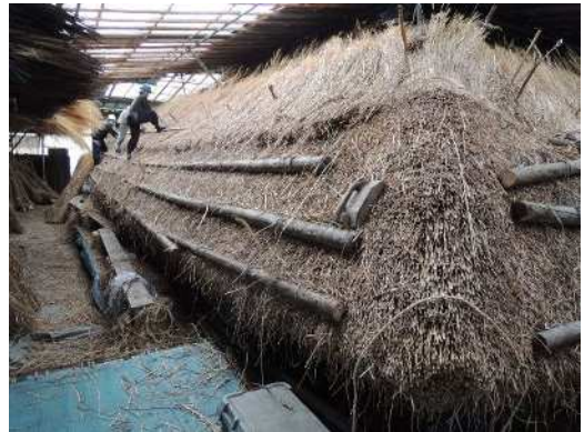
茅葺き屋根の修理の様子
