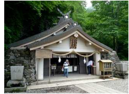
奥社本殿(昭和54年(1979))
