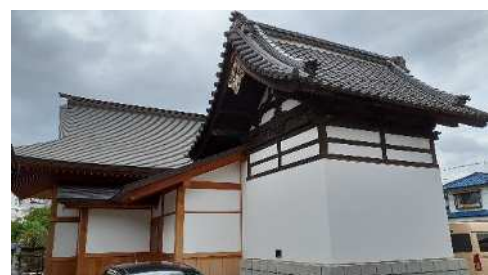
武井神社（万延元年（1860）） 上段は拝殿、下段は覆屋
