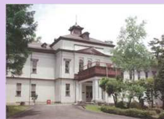
旧長野県庁舎
