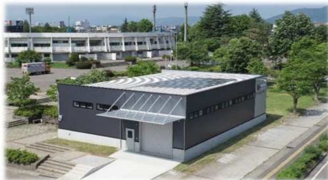
長野運動公園内の災害支援ターミナル
