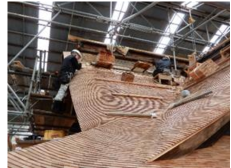
真田信之霊屋保存修理
