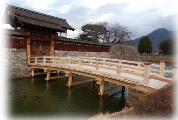
架け替え工事が完了した太鼓門前橋
