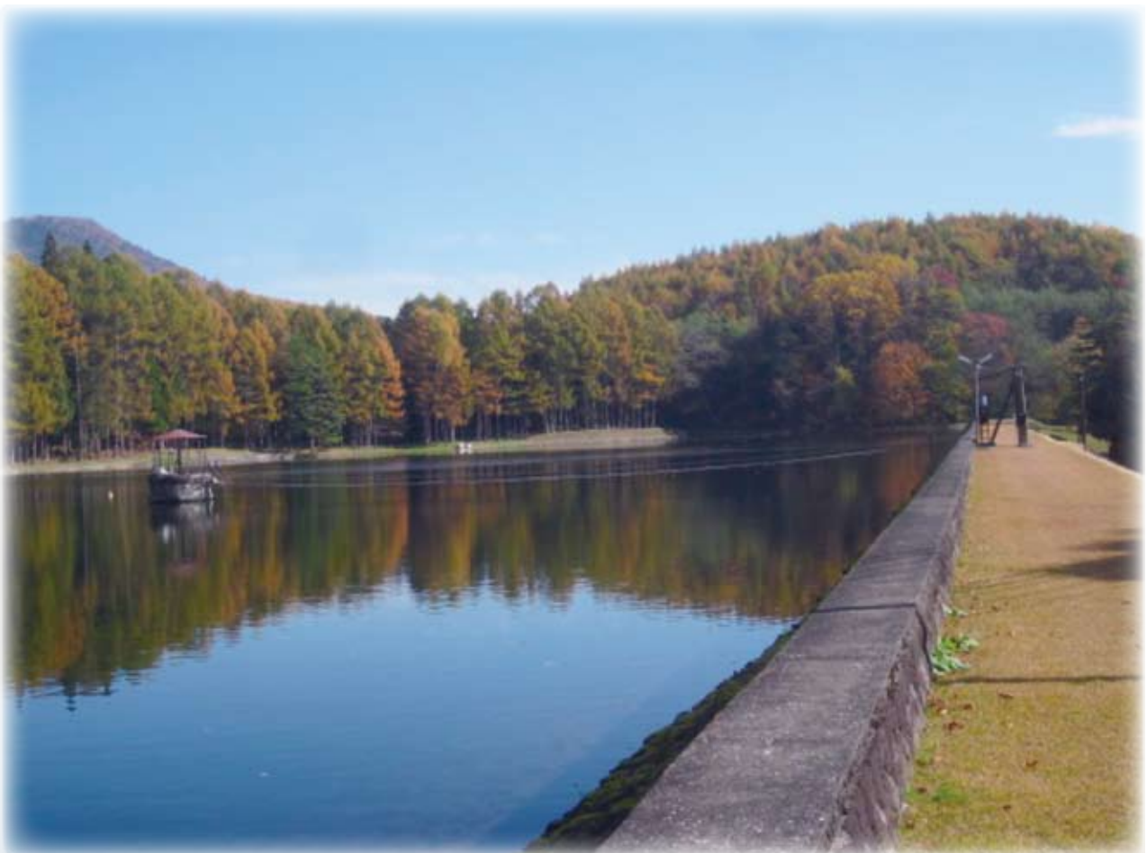
戸隠水源 長野市水道事業創設（大正4年）の水源 貯水池貯水量 225,000m 3
