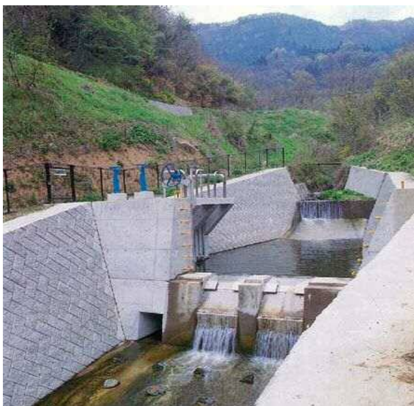
念仏寺沢水源（中条簡易水道） 平成9年竣工
