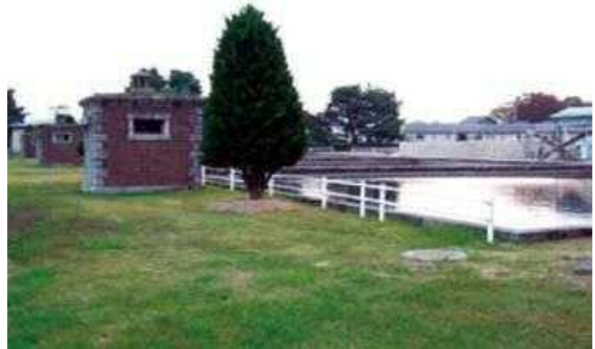
往生地浄水場
