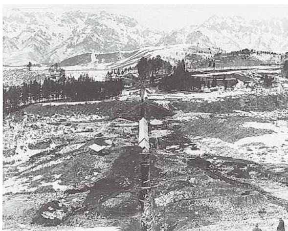
工事中の戸隠水源（大正3年）
