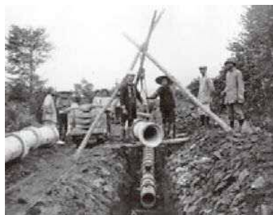
人力による導水管の布設
