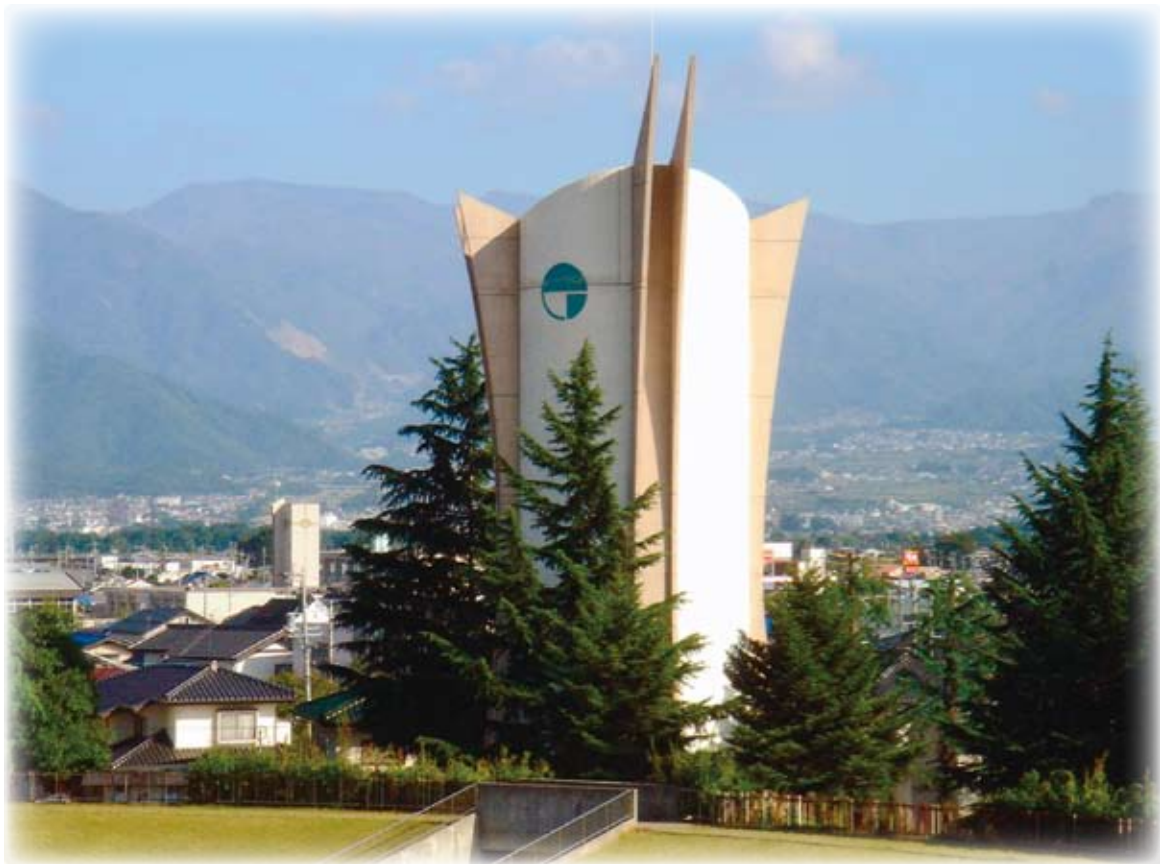
長野運動公園緊急貯水槽* 昭和59年竣工 貯水量1,000m 3
