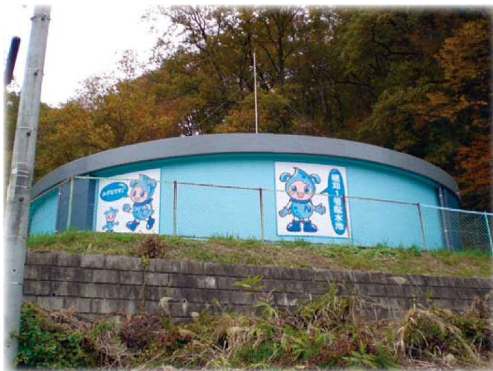
穂刈1号配水池（信州新町） 容量1,006m 3
