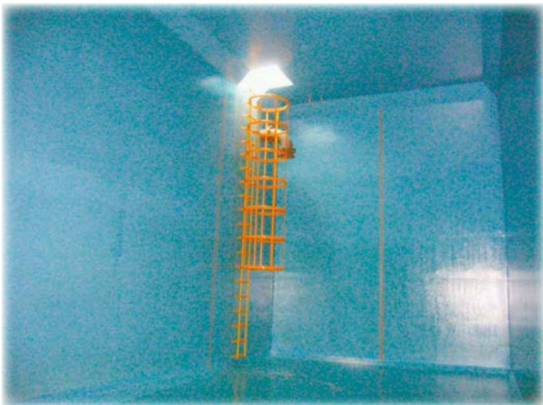
浅野配水池（豊野）内部
