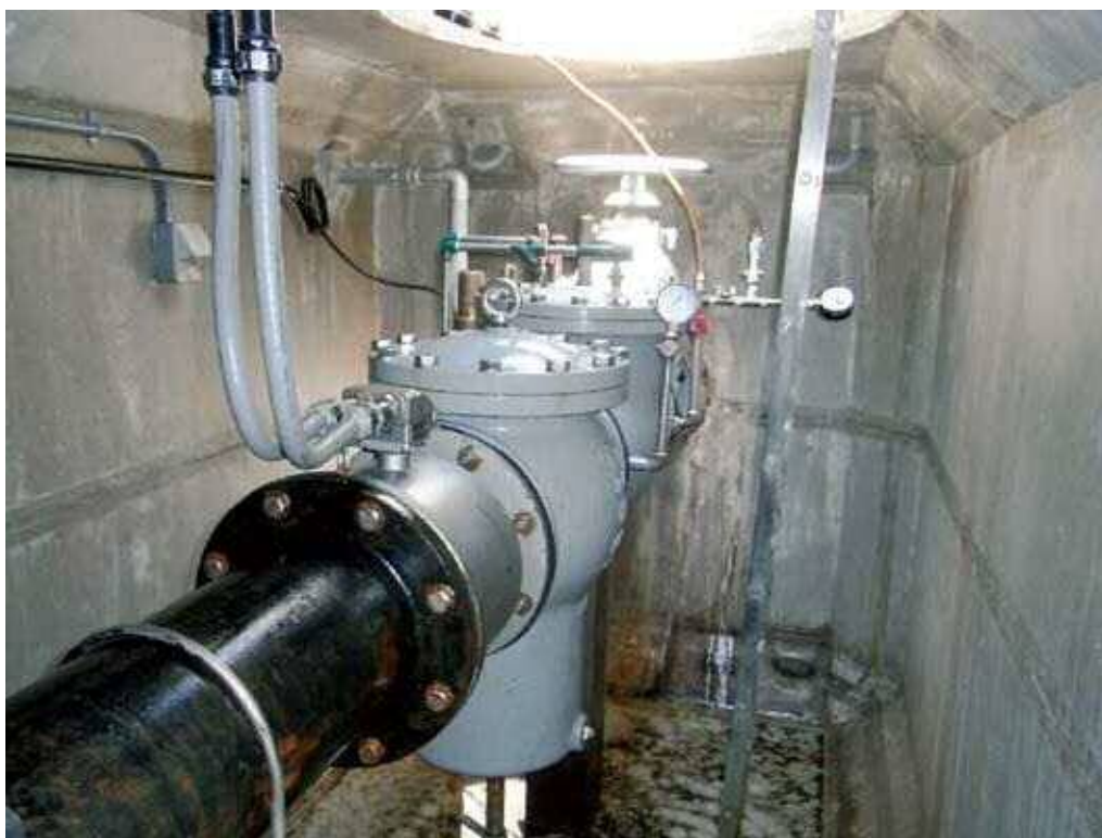
流入ピットの内部
