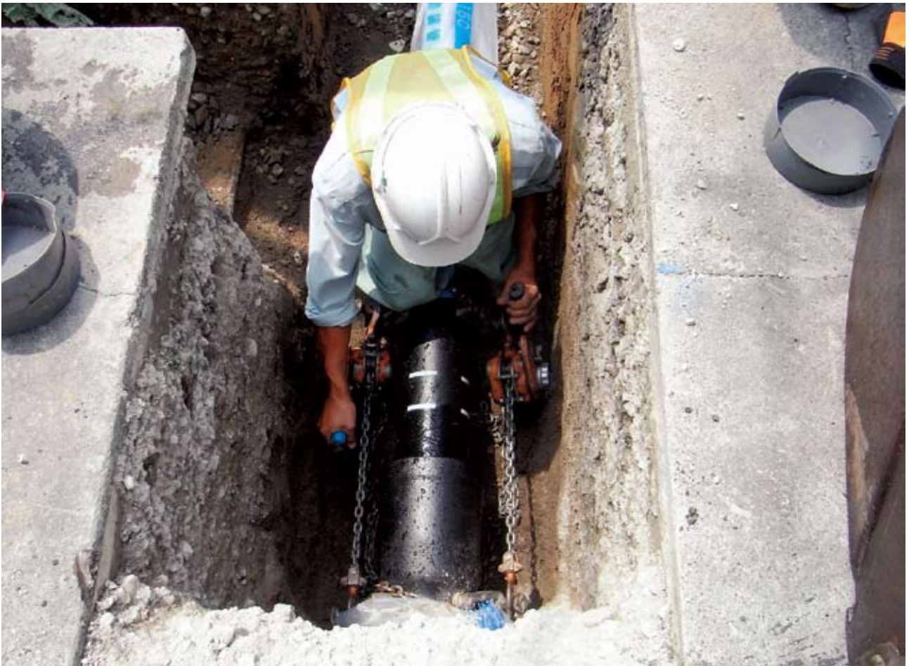
老朽管を耐震管に布設替え
