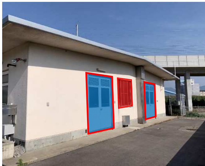
西沖浄水場 電気室
