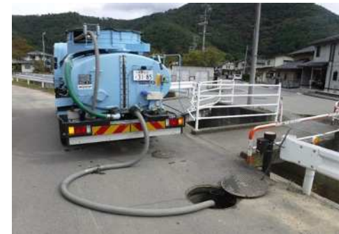
汚水吸引作業(13日間、延べ79台)
