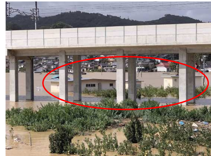
西冲浄水場 浸水状況
