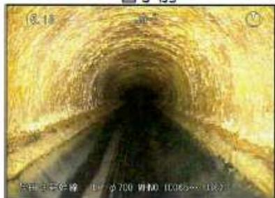
※硫化水素によりヒューム管内面が腐食
