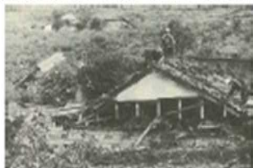
地震による地すべりで倒壊した住宅
