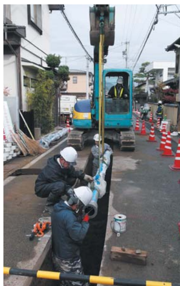
耐震管の布設状況（若里地区）
