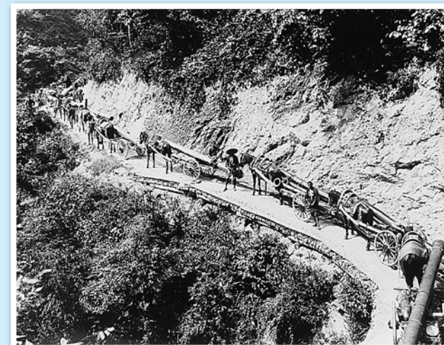
戸隠水源貯水池への材料の運搬は、急坂の連続で難航した(大正3年)
