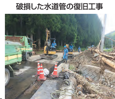
破損した水道管の復旧工事
