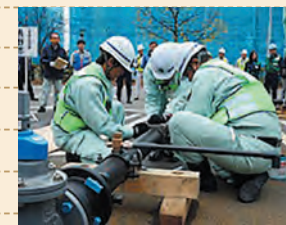
平成29年10月20日 3県合同水道防災訓練(松本市) 応急復旧活動訓練
