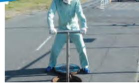
新しく布設した水道管内の洗浄・通水作業や、工事に伴う断水を行うためのバルブの開閉操作を行います。
