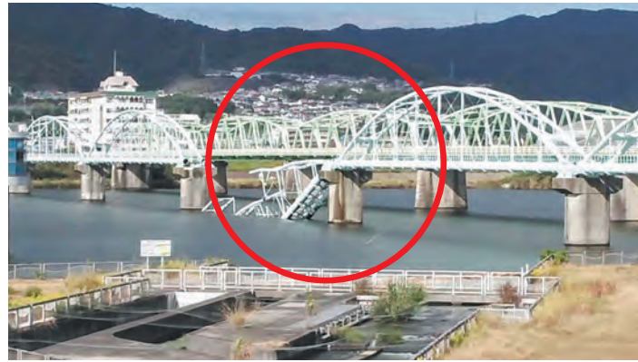
(崩落した水管橋)
