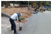
被災調査のための通水作業
