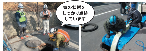
管路内の点検作業
