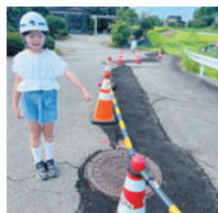
修繕後のマンホール
