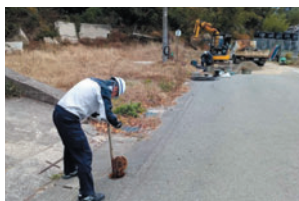
被災調査のための通水作業
