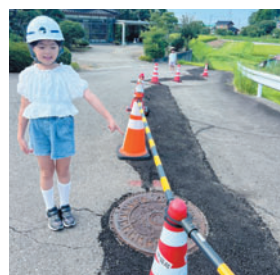
修繕後のマンホール
