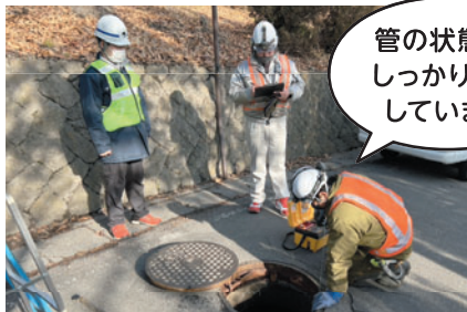
管路内の点検作業
