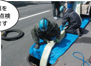
老朽管の更生工事
