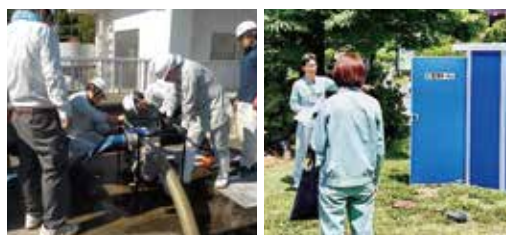
仮設ポンプの設置訓練
