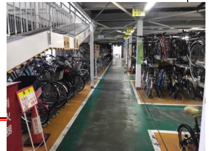
【長野駅自転車駐車場】
