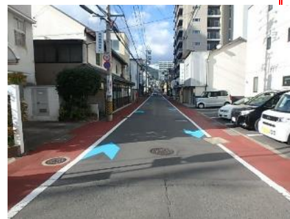
【矢羽根型路面標示(箱清水石堂線)】
