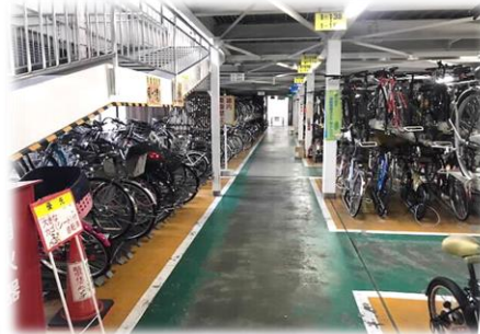
【駐輪場の大規模改修工事】
