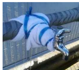
② 破裂箇所の止水の例
