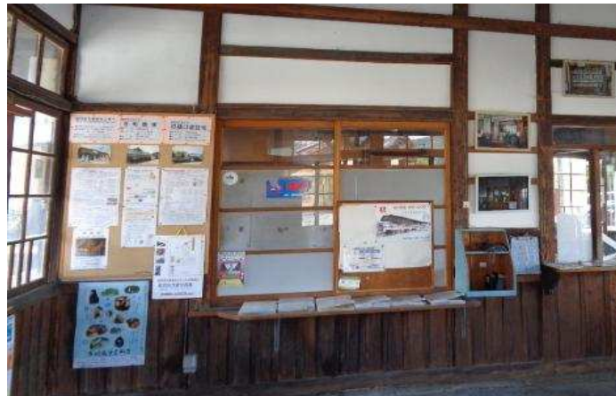
旧松代駅舎内の活用事例 「地元NPO法人による観光情報コーナーの設置」
