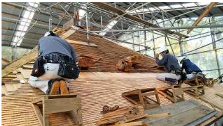
県宝真田信弘霊屋保存修理
