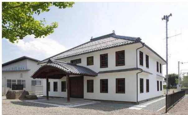
旧作新学校本館保存修理 (R7完了)
