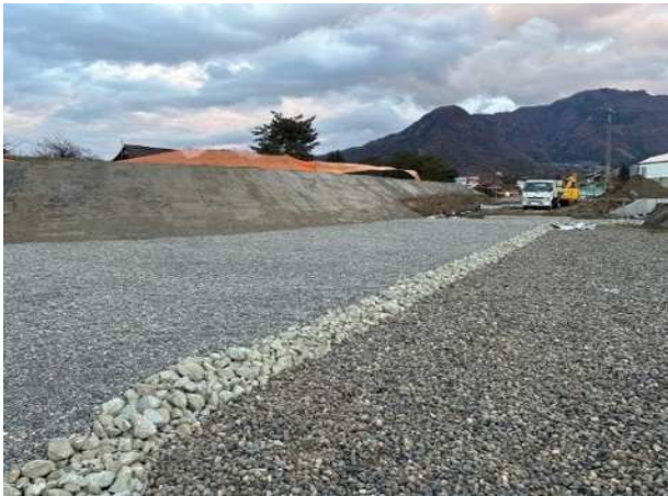
二の丸遺構外保存整備工事
