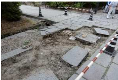
敷石更新作業状況
