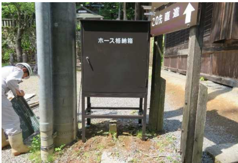
←小口径ホース格納小屋設置工事
