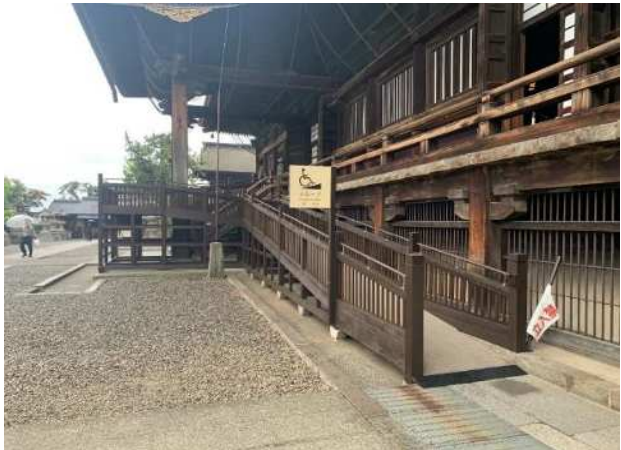
善光寺本堂スロープ設置
