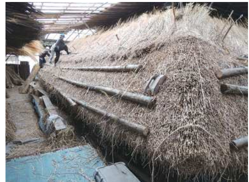
茅葺屋根の修理の様子
