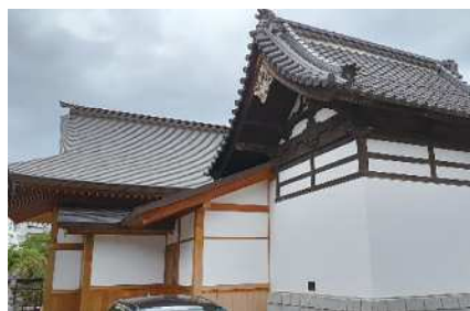
武井神社(万延元年(1860)) 上段は拝殿、下段は覆屋
