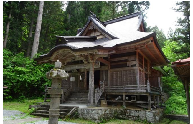
白髯神社拝殿 外観北東より見る
