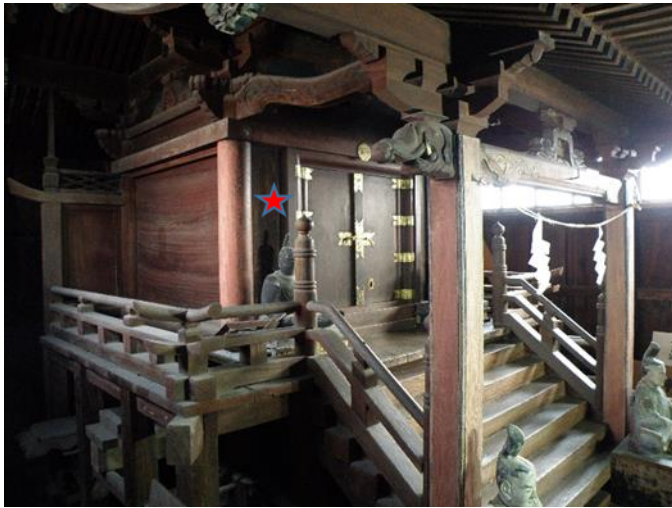
離山神社本殿 外観南西より見る
