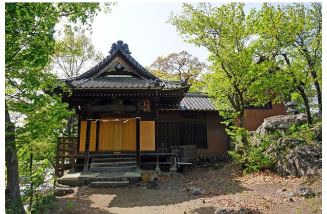
離山神社拝殿・祝詞殿及び上屋 外観東より見る
