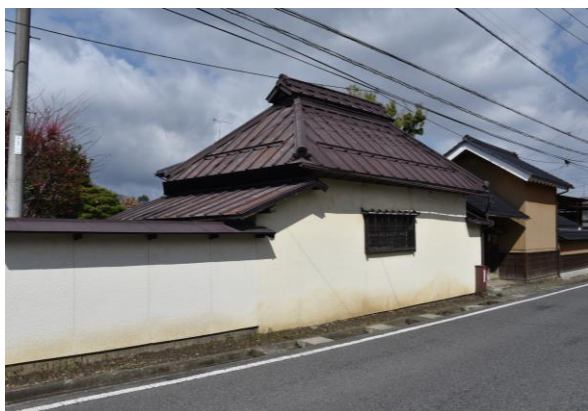
現状変更前 外観（東面）
