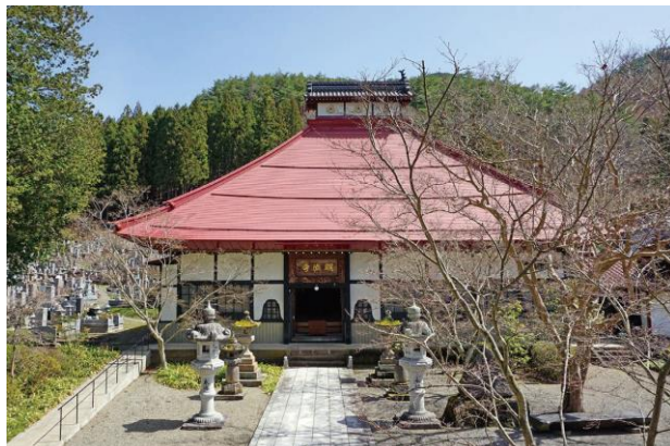
明徳寺本堂 外観西面
