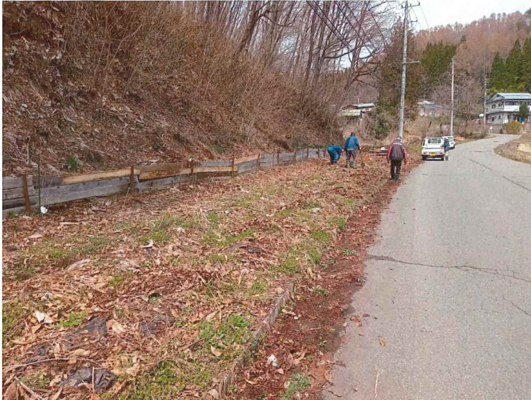
施工前（既存球根等の掘出し等）
