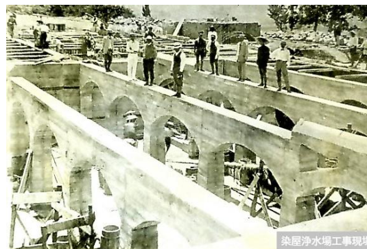
染屋浄水場工事現場
