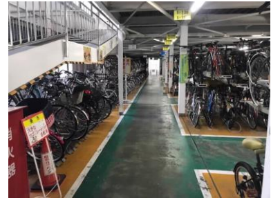
【長野駅自転車駐車場】
