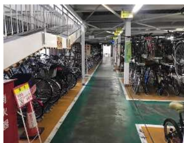
【長野駅自転車駐車場】
