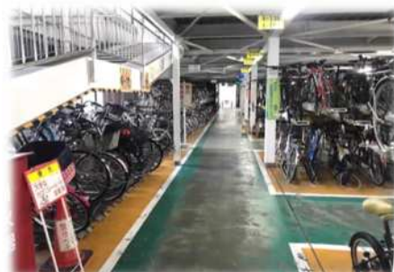
【駐輪場の大規模改修工事】
