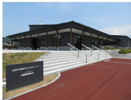
（長野市豊野防災交流センター外観）
