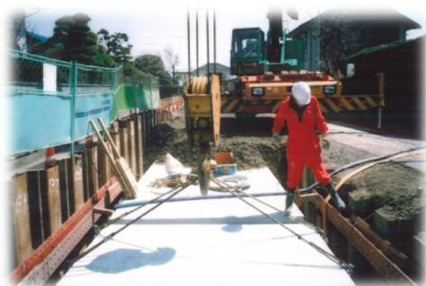
浅川 1 号雨水幹線工事 状況写真
