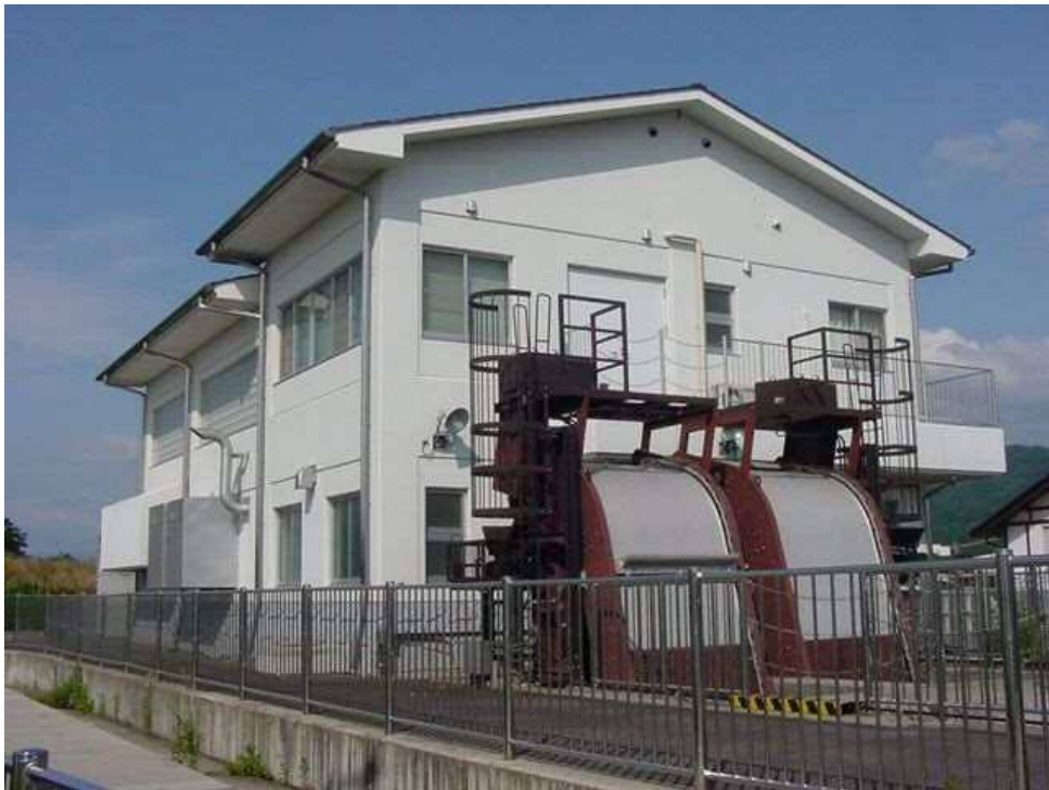
長野市公共下水道事業（雨水） 寺尾ポンプ場 平成12年供用開始
