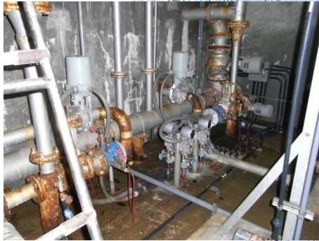
本郷浄水場内の状況
