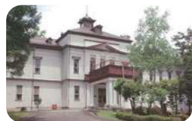
▲ 旧長野県庁舎
