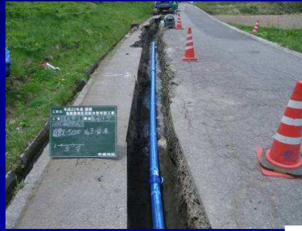
配水用ポリエチレン管布設状況
