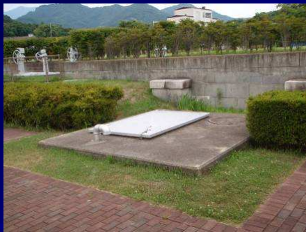
夏目ヶ原浄水場 弁室外観
