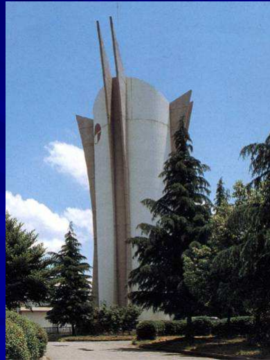
長野運動公園緊急貯水槽
