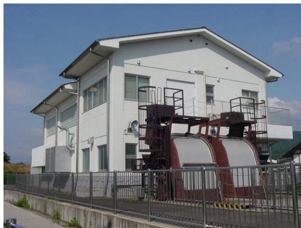
寺尾ポンプ場
