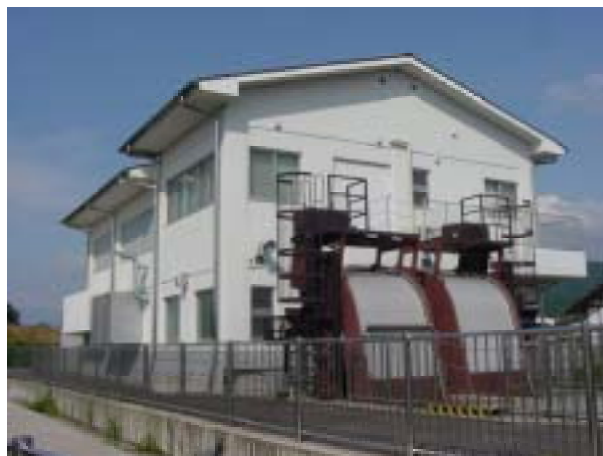
寺尾ポンプ場
