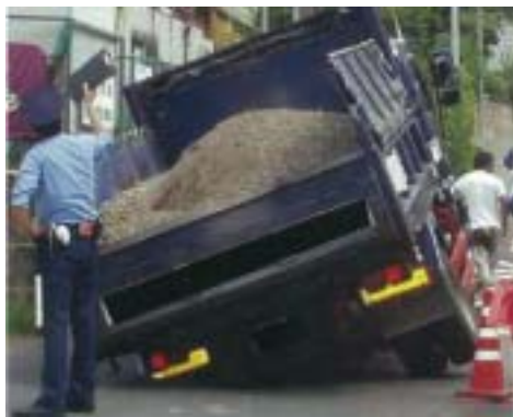
下水道管破損による道路陥没事例（横浜市、東京都）
