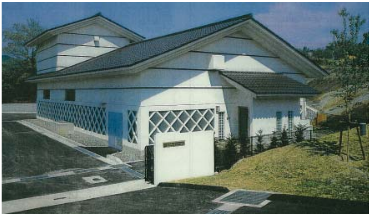
信州新町浄化センター
