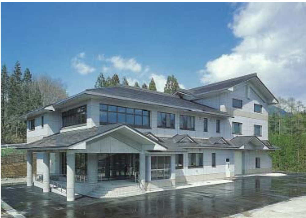
戸隠高原浄化センター
