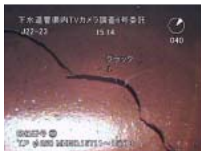
管渠内部(側面)
