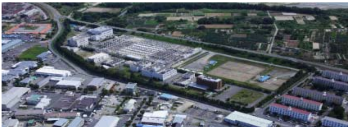
東部浄化センター 平成 19 年
