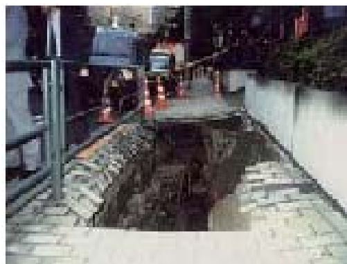
下水道管破損による道路陥没事例（横浜市、東京都）
