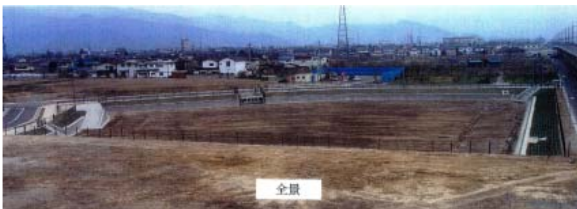
今井雨水調整池 平成 12 年
