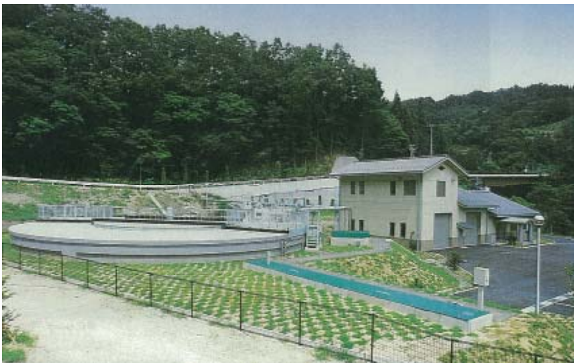
中条浄化センター
