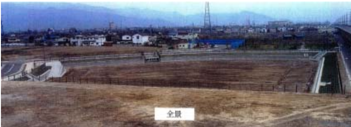
今井雨水調整池 平成 12 年
