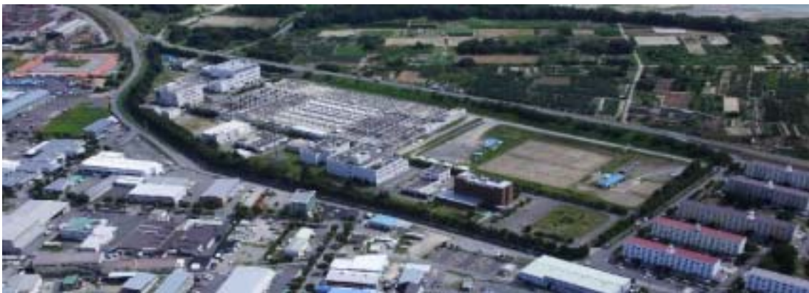
東部浄化センター 平成 19 年
