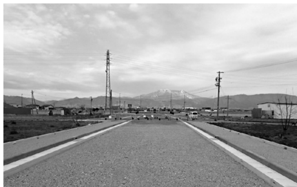
古牧朝陽線から国道18号長野東バイパスに向かったの整備状況
